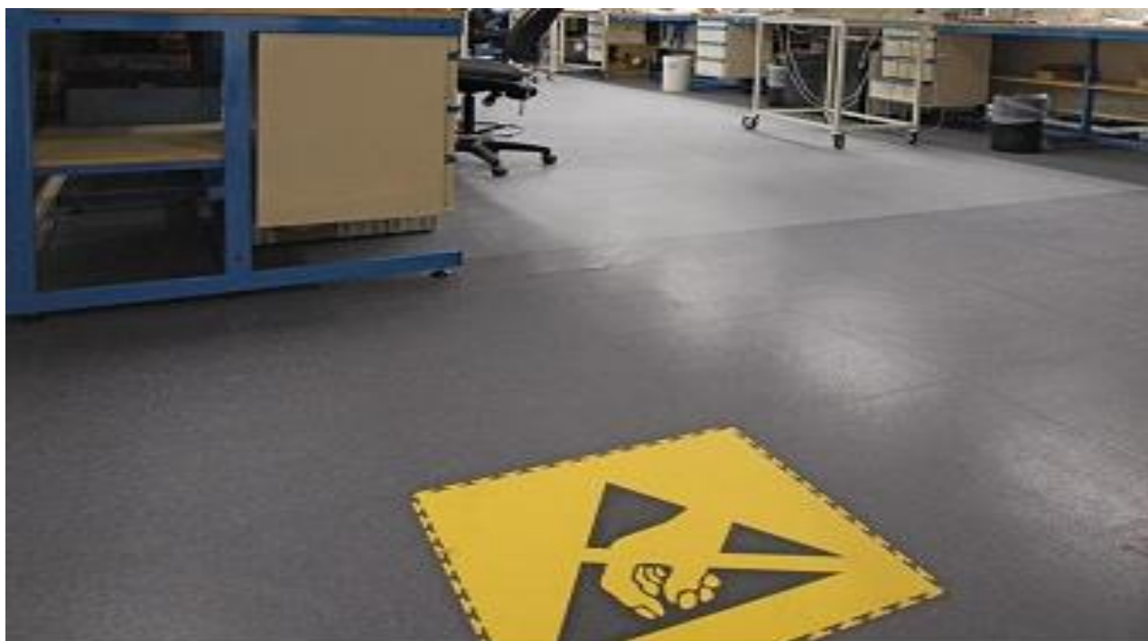
ESD-Erdungsfolienverlegung
